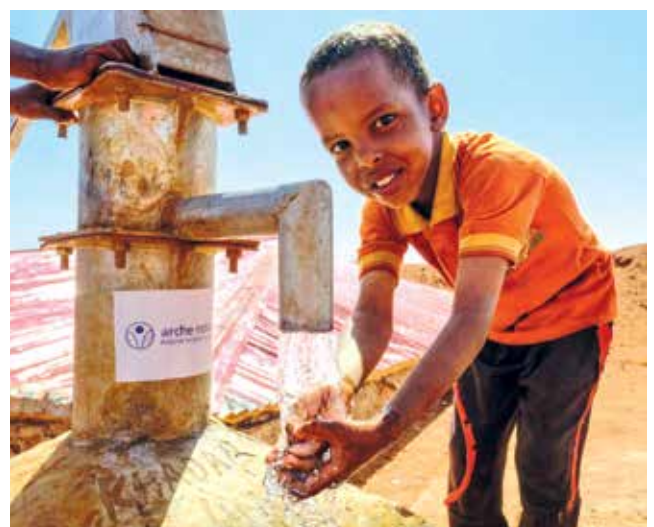
Ein Flachbrunnen und mehrere Regenwasserspeicher versorgen die Menschen dauerhaft mit sicherem Trinkwasser.
