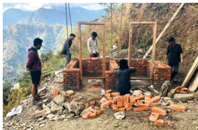
An insgesamt 12 Schulen wurden Wasser- und Sanitäranlagen verbessert.
